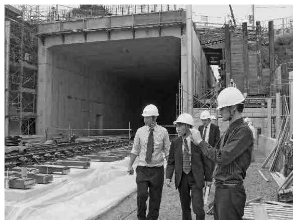
写真3 成田新高速鉄道線 現場視察状況 厳しい工期の制約下での施工と、貴重な生態系の保護を実現すべく、施工技術の粋を集めた貴重な現場である
